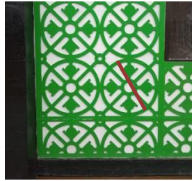
Gambar 11. Ornamen pada dinding Gapuro Nusantara.
